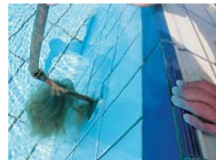
Hinter der Ansaugöffnung sind die Haare nun stark verknotet. Selbst mit großen Kräften ist ein Herausziehen nicht mehr möglich.
